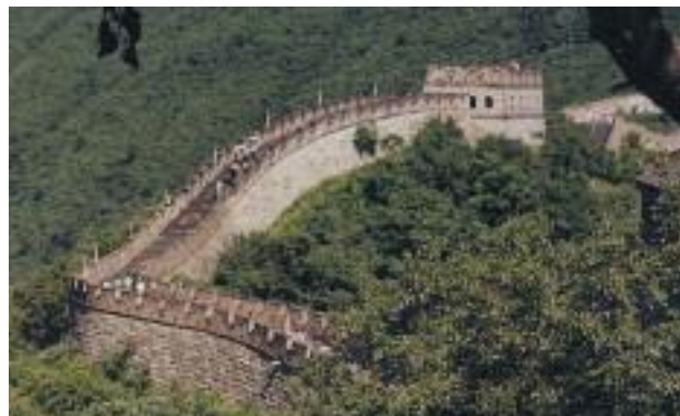
La Gran Muralla China, data desde hace unos 2,200 años, fue construida como un muro de retención de doble lado. El suelo entre los dos muros, fue una mezcla de arcilla y grava reforzada con ramas de Tamariz (Cedro Salado). Los muros Allan Block emplean una "Tecnología antigua con materiales nuevos."
