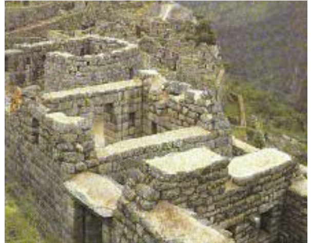
La construcción sin mortero ha sido usada por siglos.
